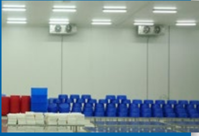
▲ Güntner unterstützt Hung Vuong mit Luftkühlern CUBIC Vario GGHF, die vom TÜV Süd als HACCP-ready zertifiziert sind, bei der Durchführung des HACCP-Konzeptes
