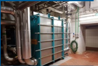
▲ Zusammen 32 MW Plattenwärmeübertrager-Leistung kühlen in Tychy Würze mit fünf thermowave PWÜ vom Typ TL 500 TCGL von 99 °C auf 10 °C ab.
